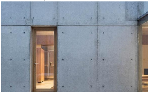
Exemple de béton banché brut
